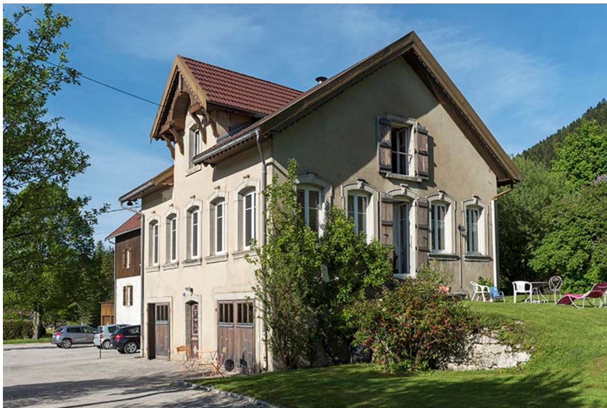
Maison : façades antérieure et latérale droite.
