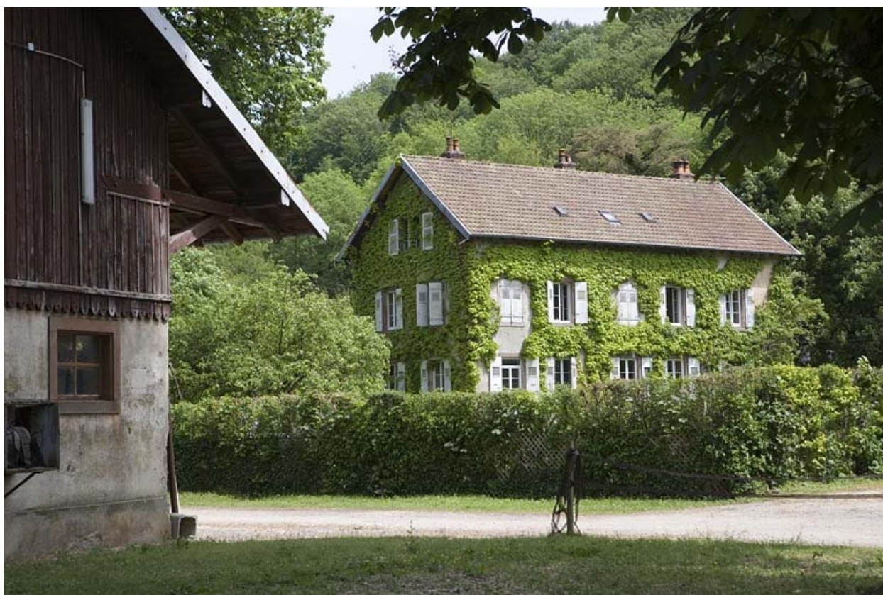
Maison de direction. Façade antérieure.
