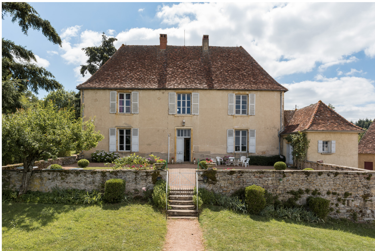
Façade antérieure du logement
