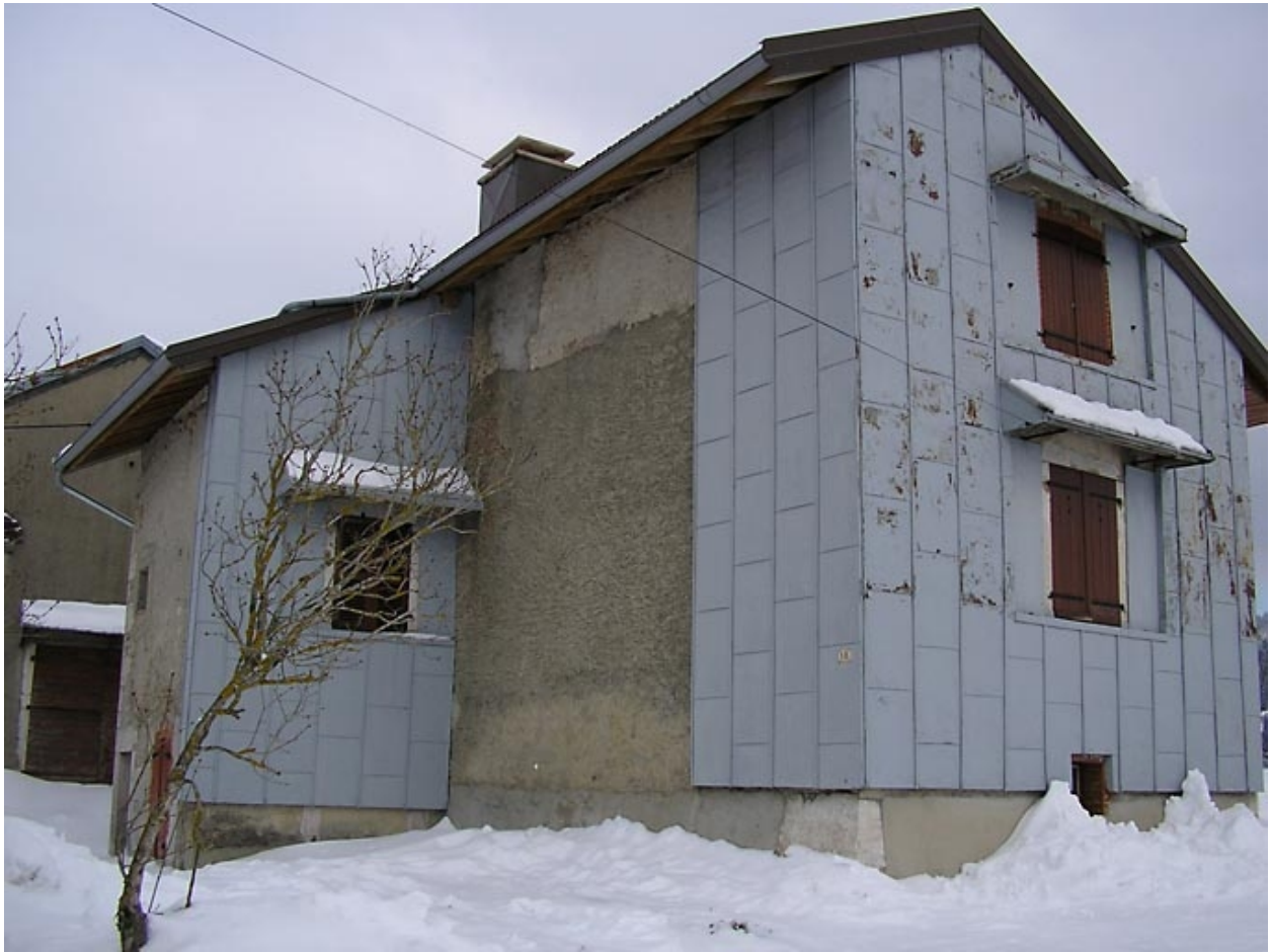
Vue du pignon sud-ouest.
