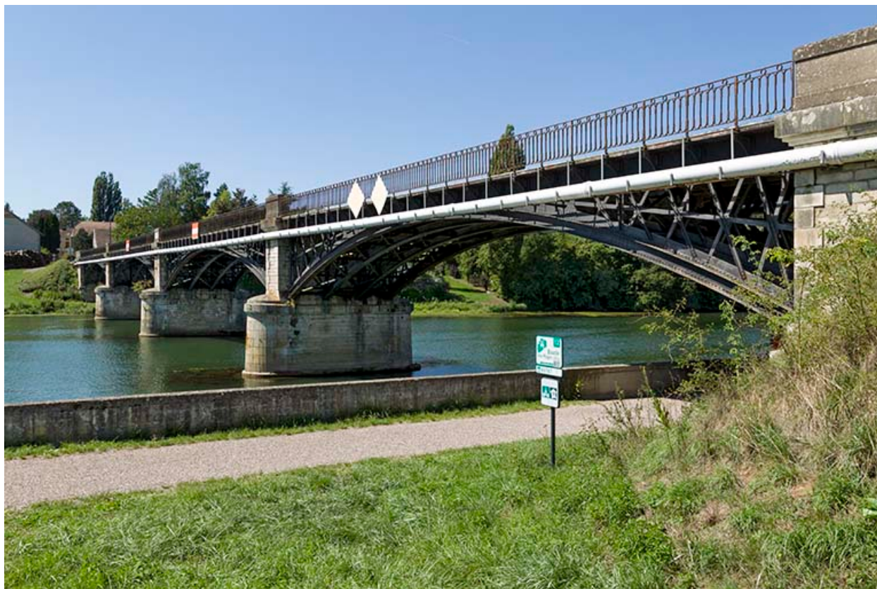
Le pont de Prantigny.
