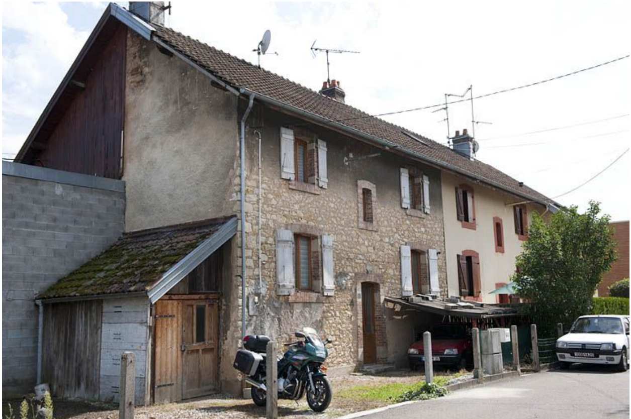
Rue de Verdun. Façade antérieure d'une habitation.
