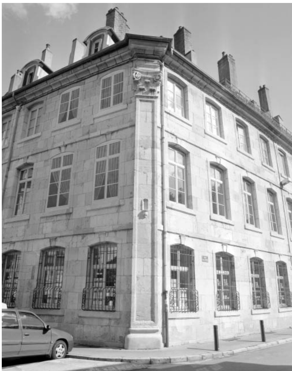
Vue d'ensemble rapprochée.
