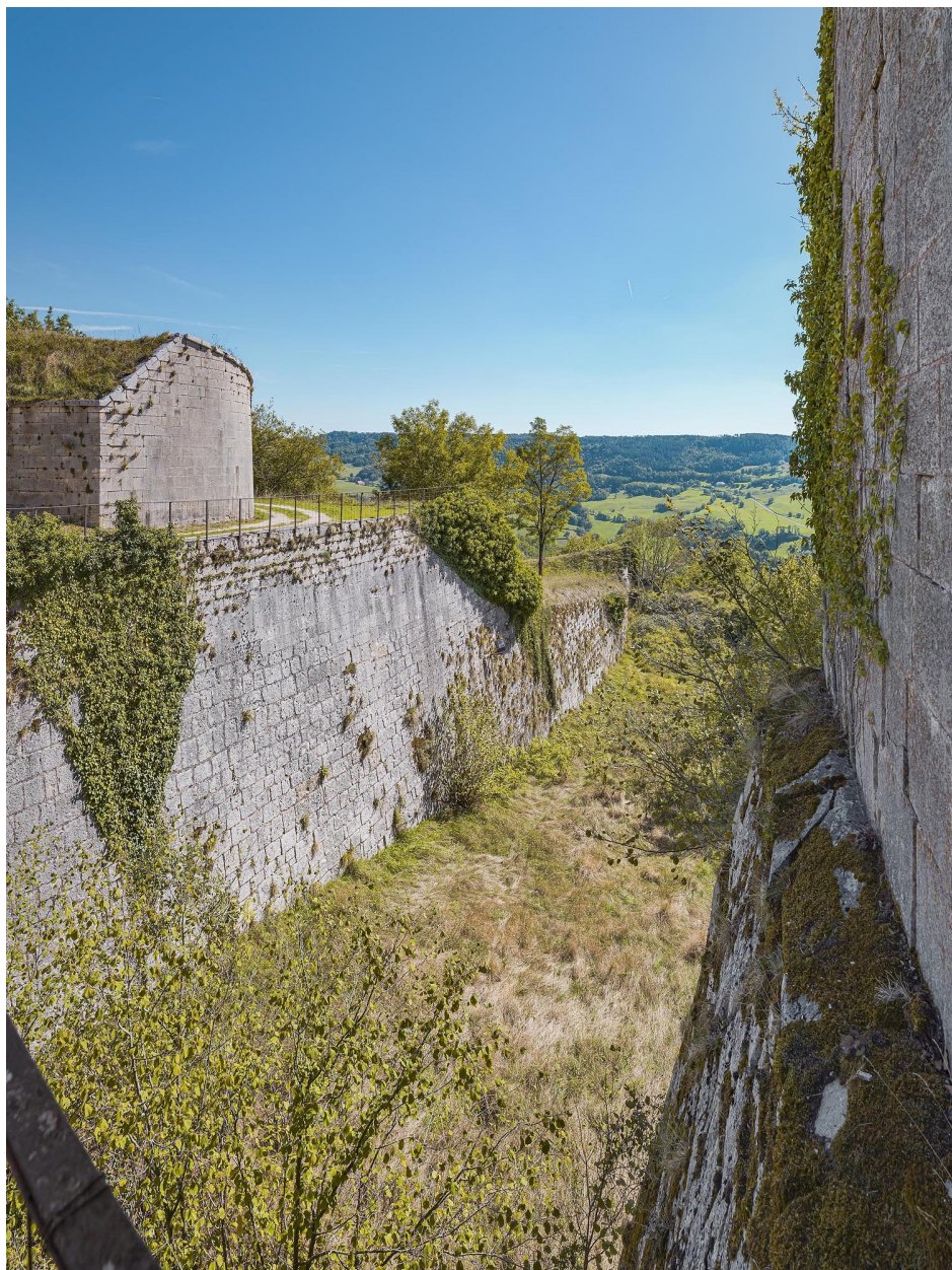
Le mur de contrescarpe et le fossé.
