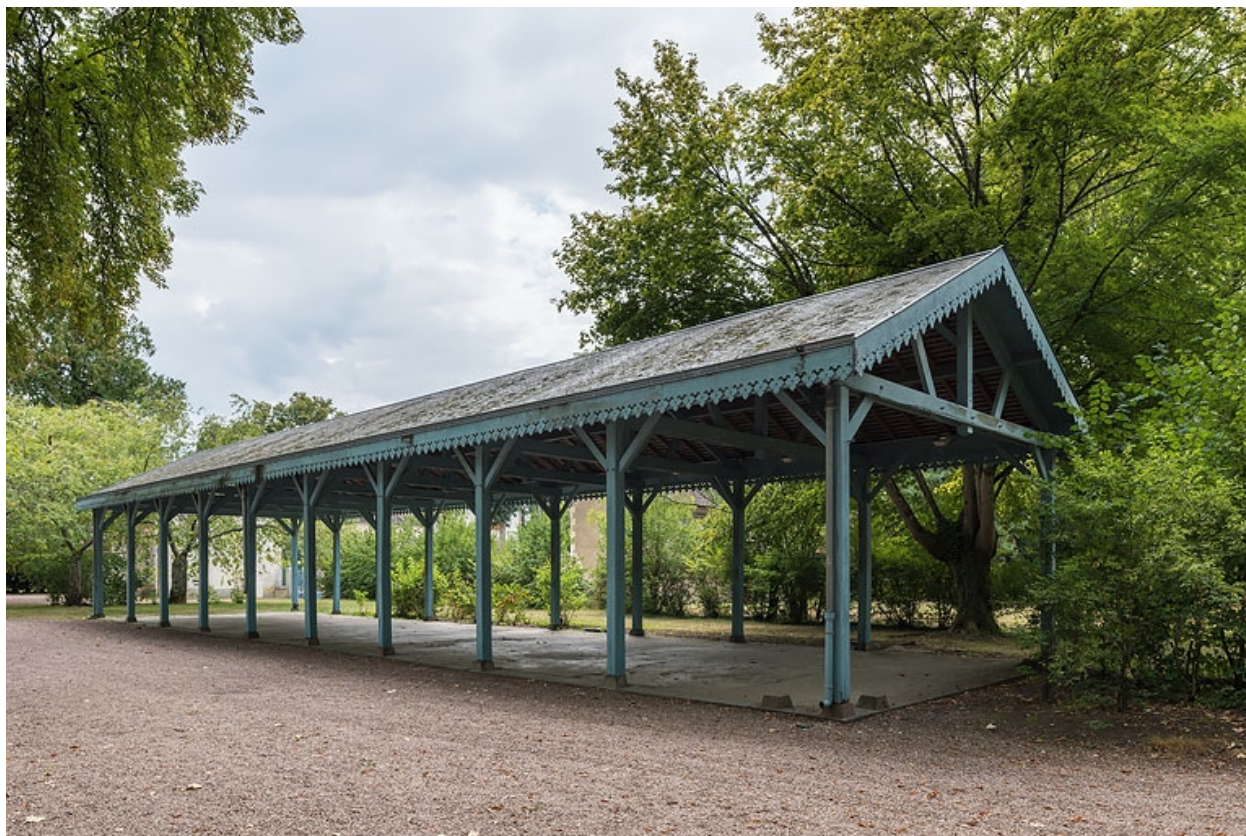
Allée couverte après reconstruction.
