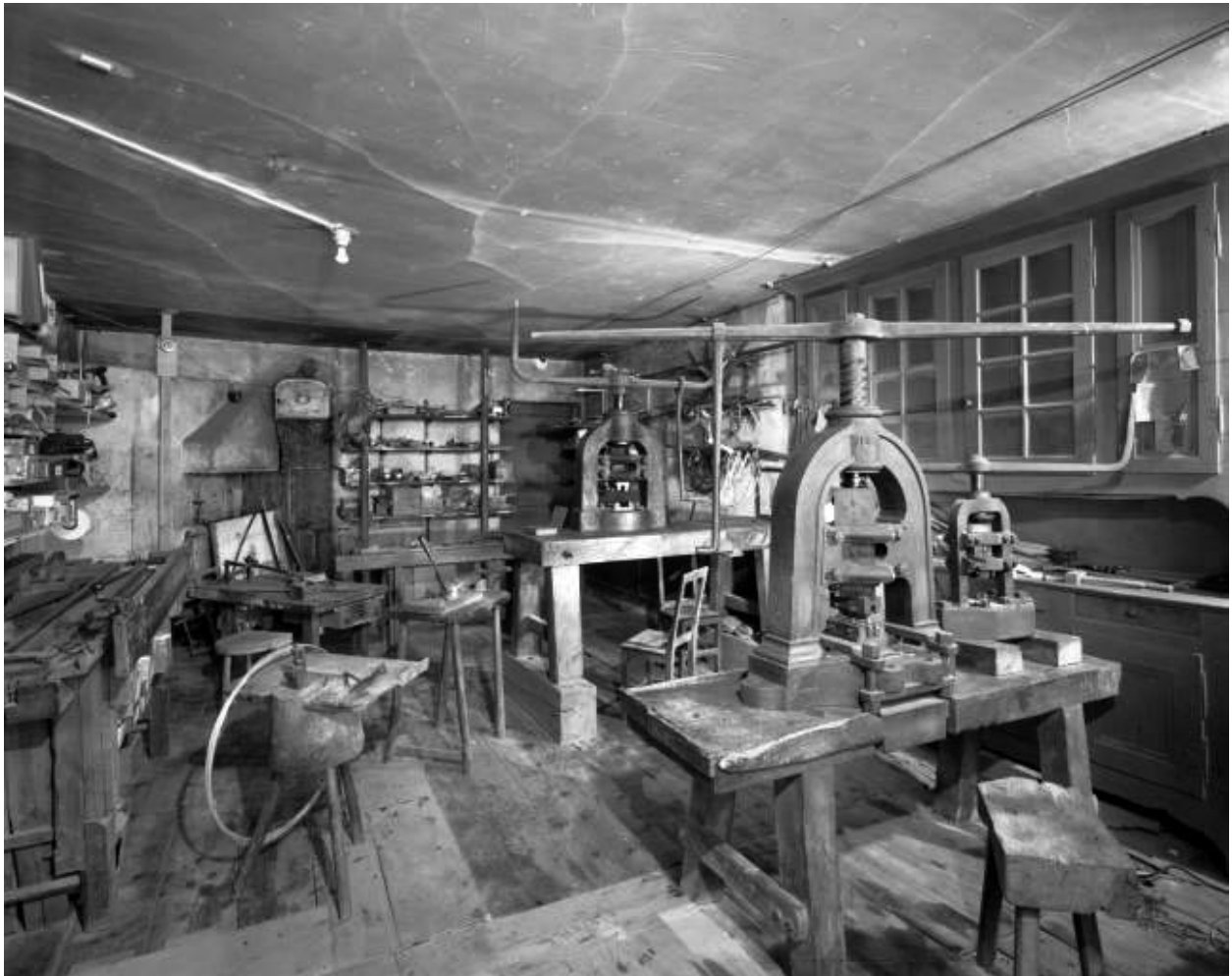
Intérieur de l'atelier de fabrication.
