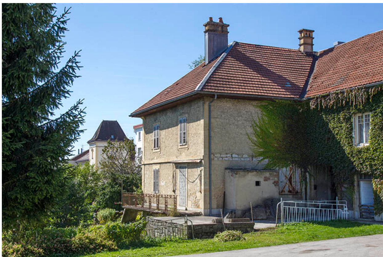
Corps sud : façades postérieure et latérale gauche.
