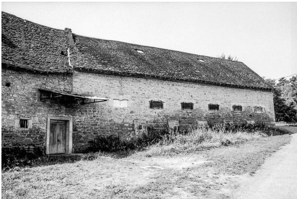
Partie agricole : façade sur la rue.
