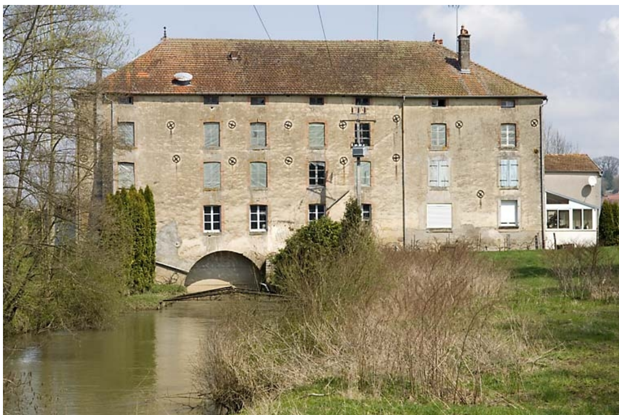
Façade postérieure vue de face.
