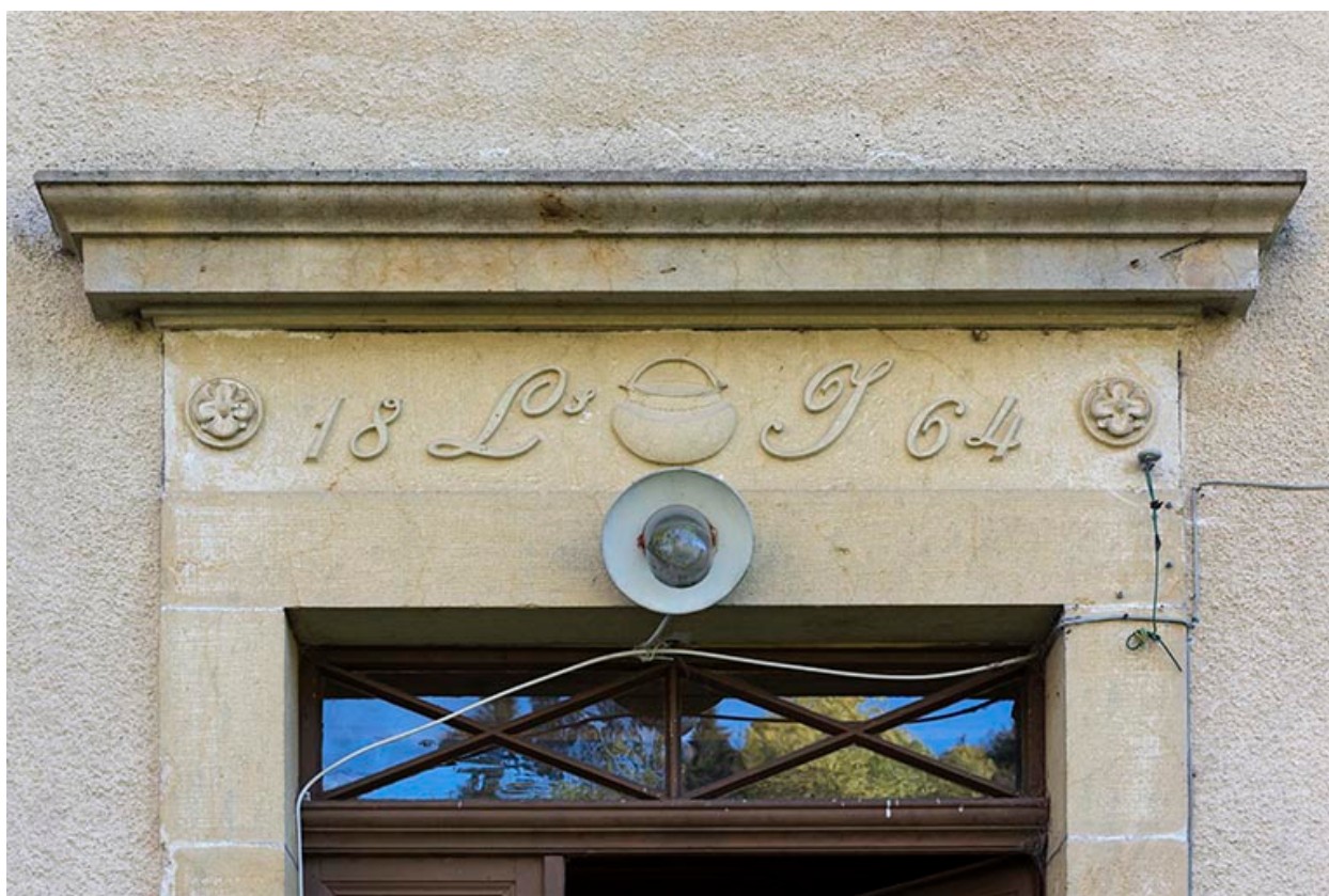
Façade antérieure : linteau sculpté et daté 1864.
