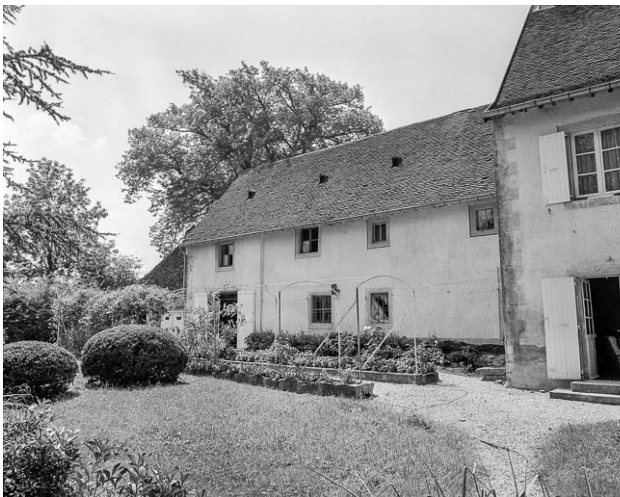
Ferme n° 16 : façade postérieure.
