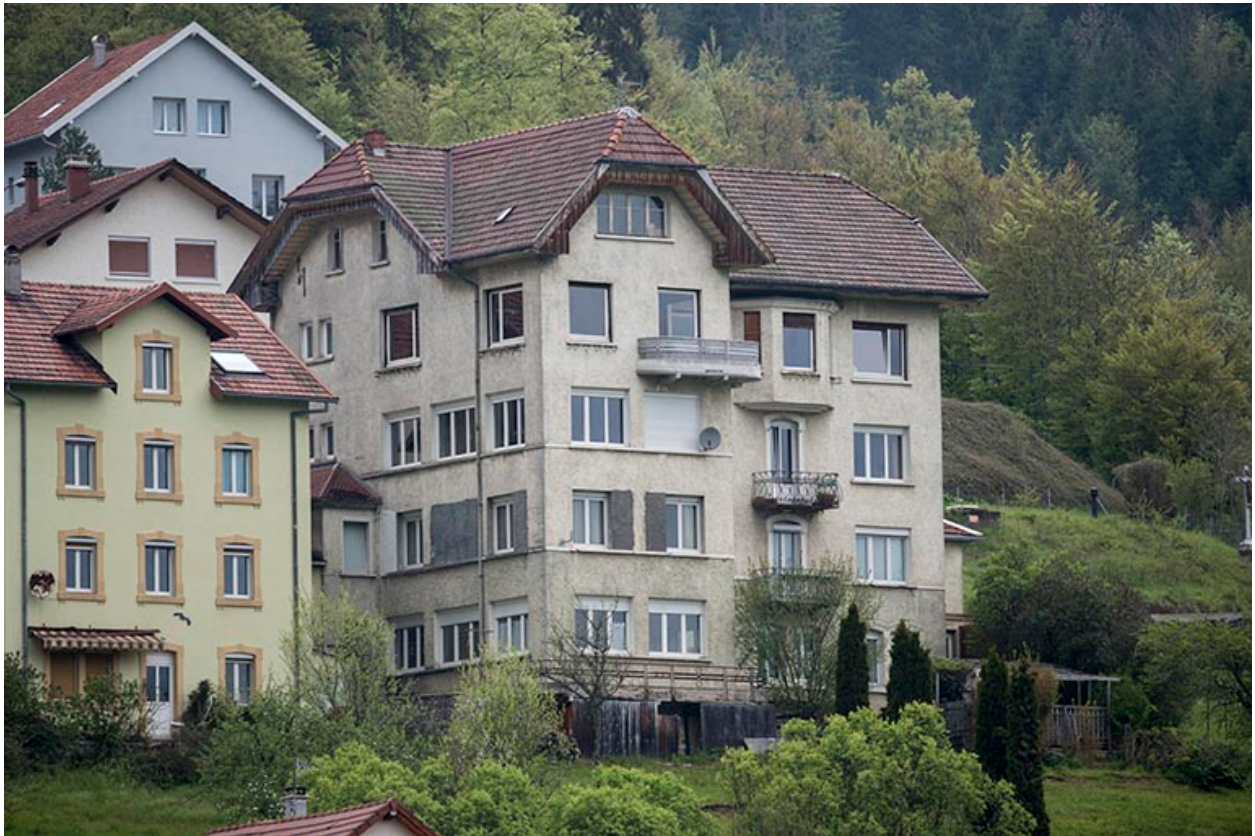
Façades postérieure et latérale droite.
