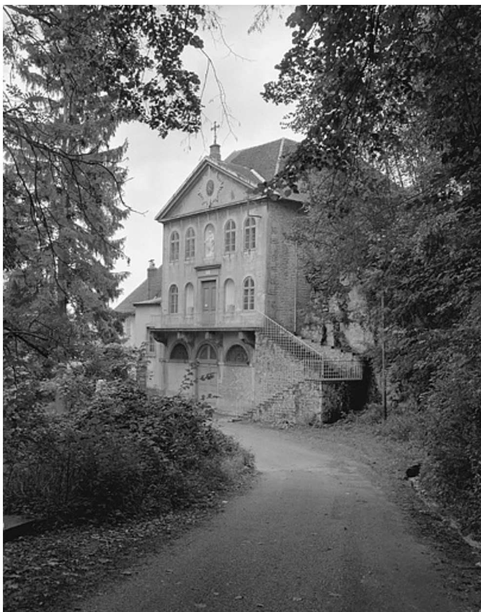
Façade antérieure du bâtiment B.
