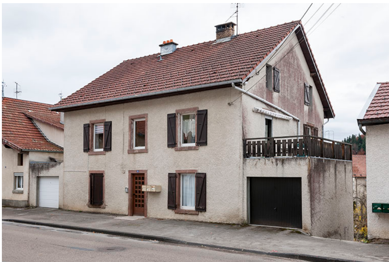
Façades antérieure et latérale droite.
