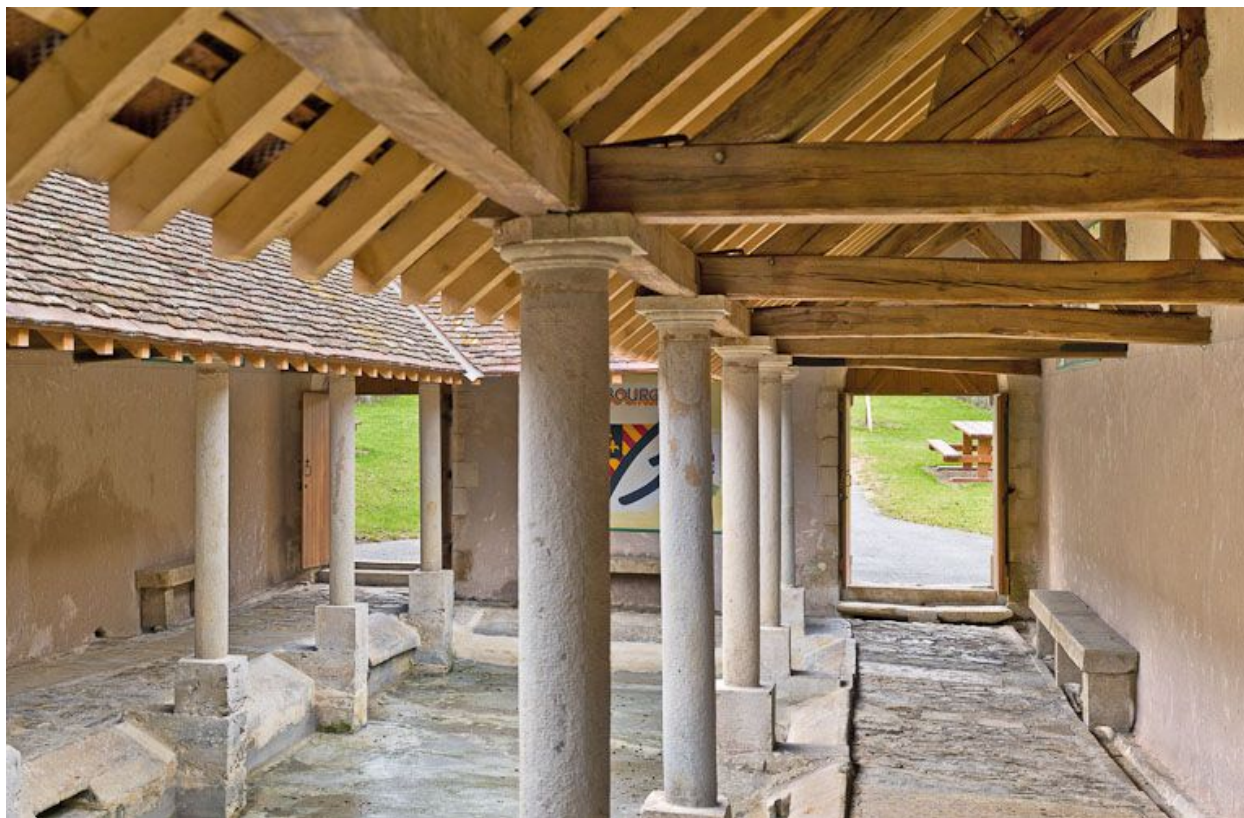
Vue de l'intérieur du lavoir.
