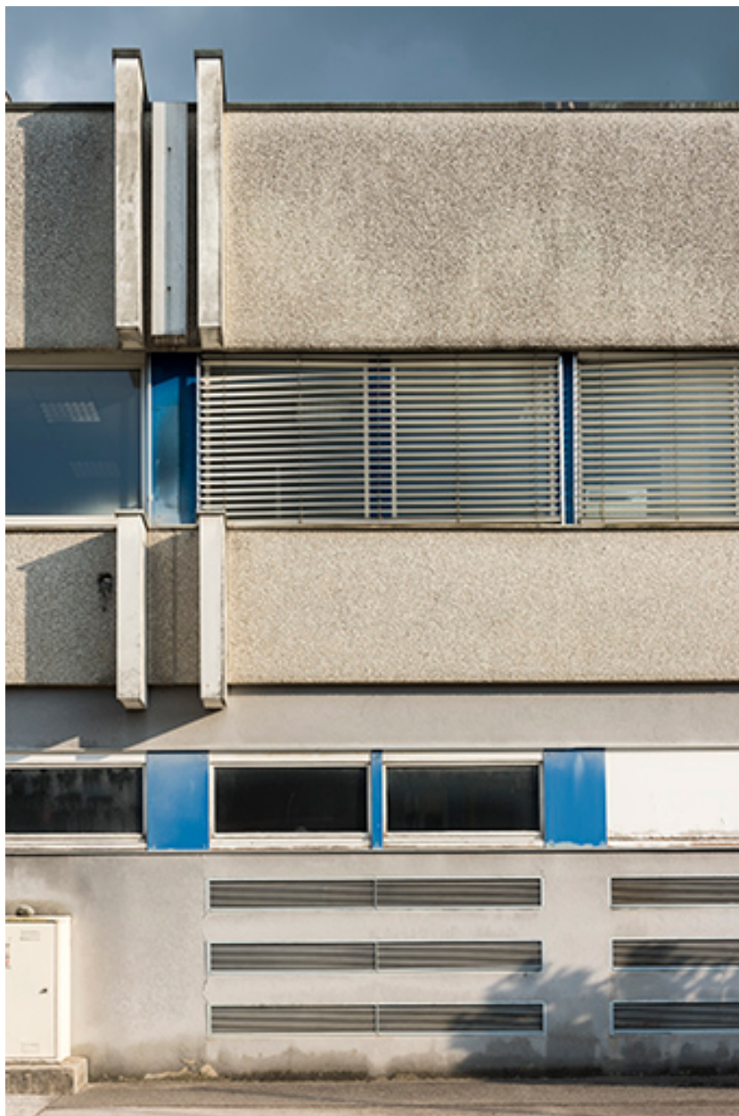
Façade ouest : une travée de l'atelier de 1970.
