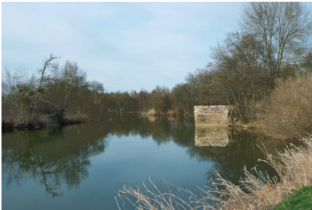
Pile de l'ancien pont à bascule.
