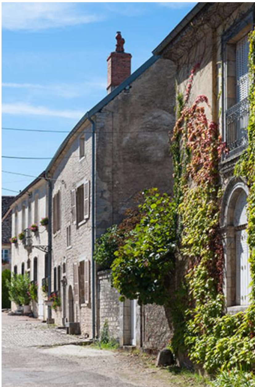
Rue du Bourg, vue depuis l'est
