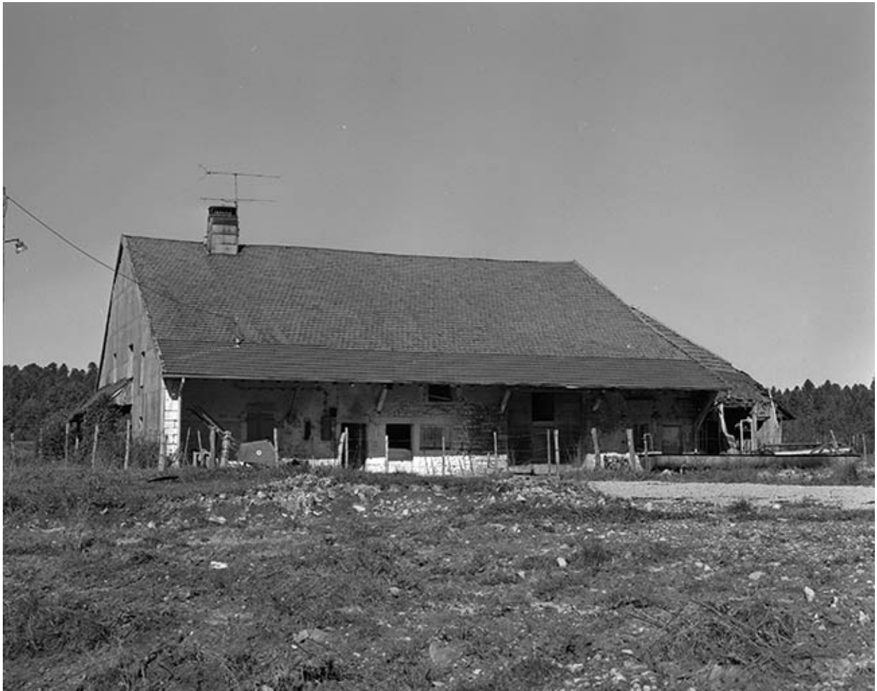
Façade latérale droite.
