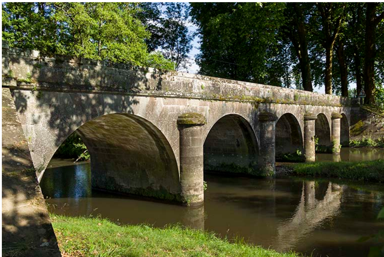
Vue du pont en aval.
