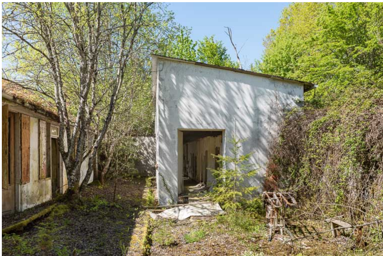
Bâtiment des bains, vue extérieure.
