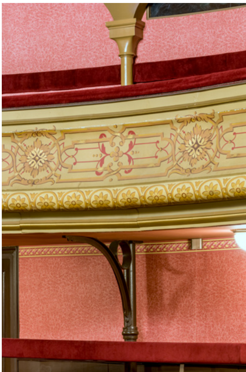
Garde-corps du 3e balcon et poteaux métalliques.
