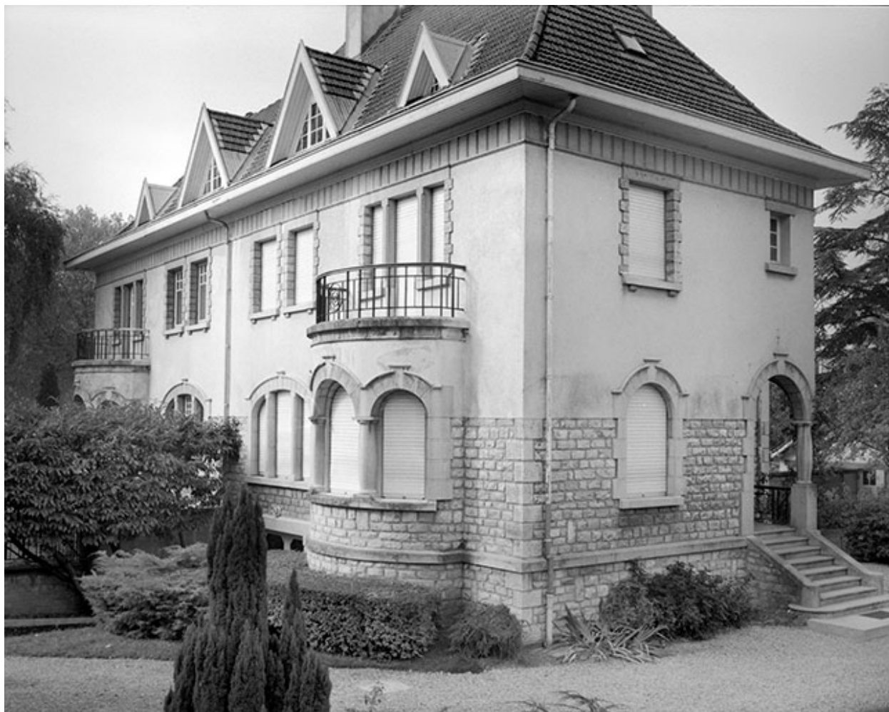
Façade antérieure et face droite.
