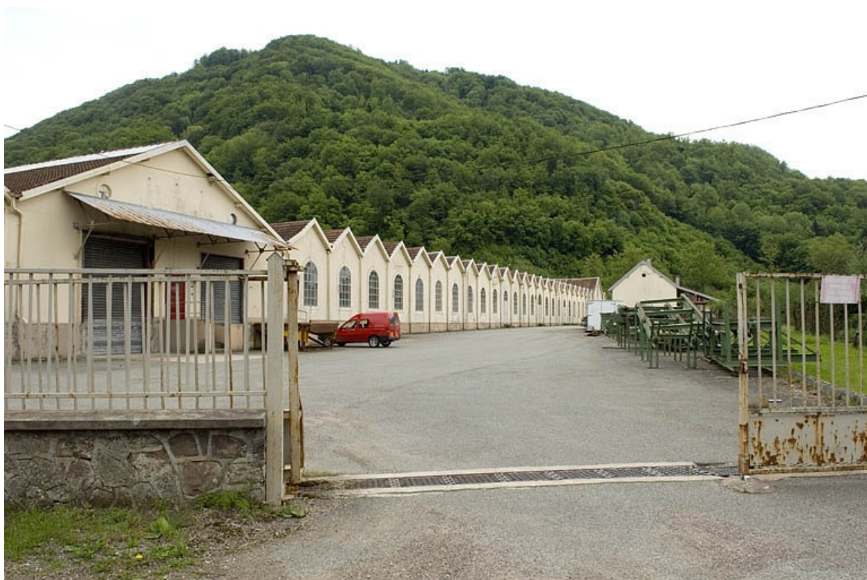
Pignons de l'atelier de fabrication depuis l'entrée.
