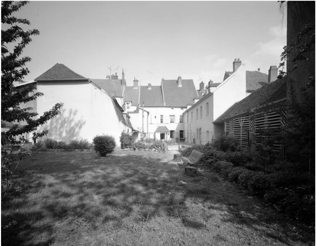
Façade postérieure : vue éloignée.
