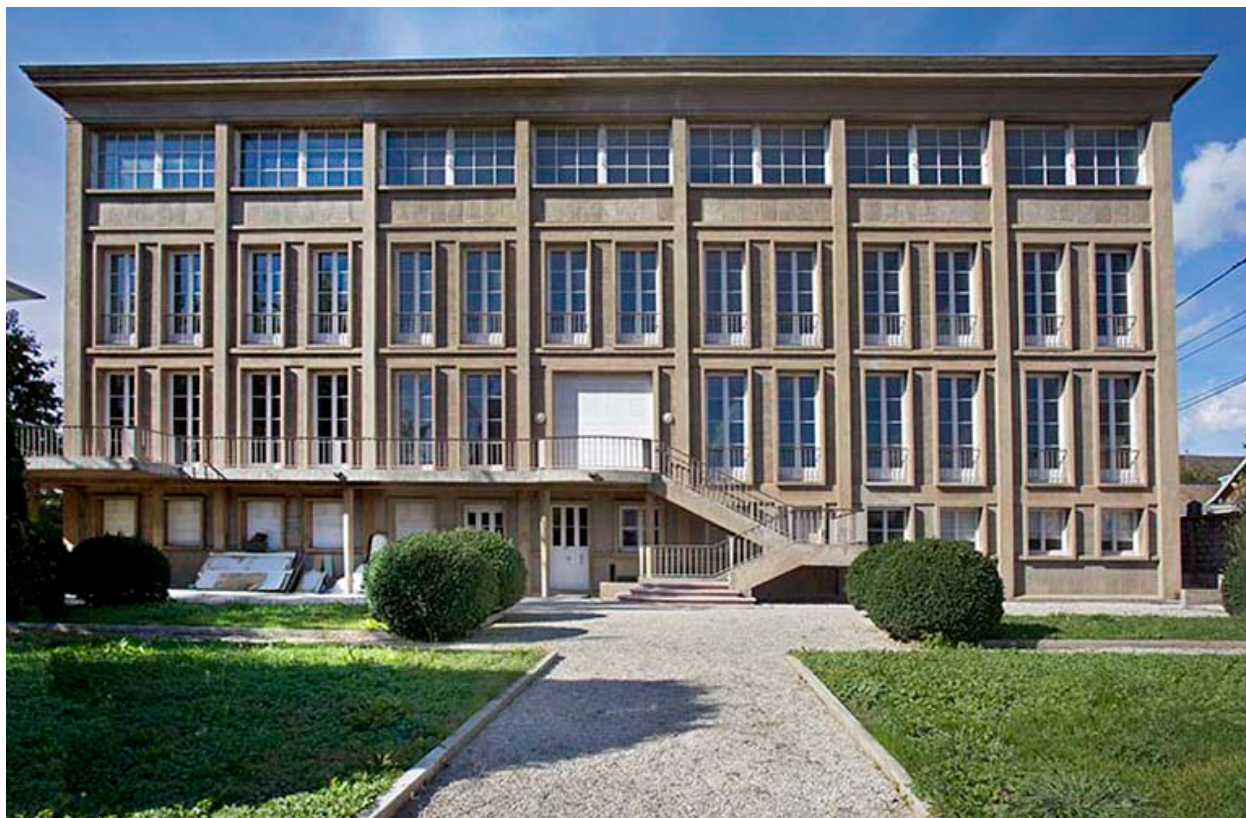
Usine Raymond Dodane (1939-1943), 5-7 avenue de Montrapon.
