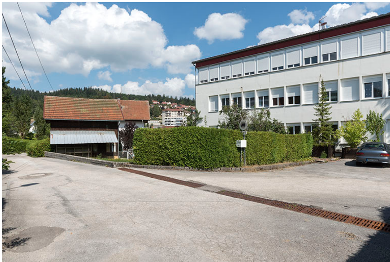
Bûcher, maison et usine (façade latérale droite).
