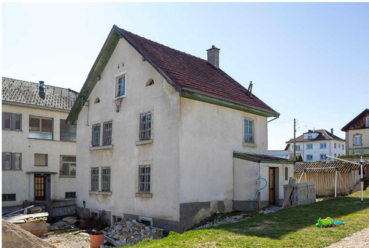
Façades postérieure et latérale droite.
