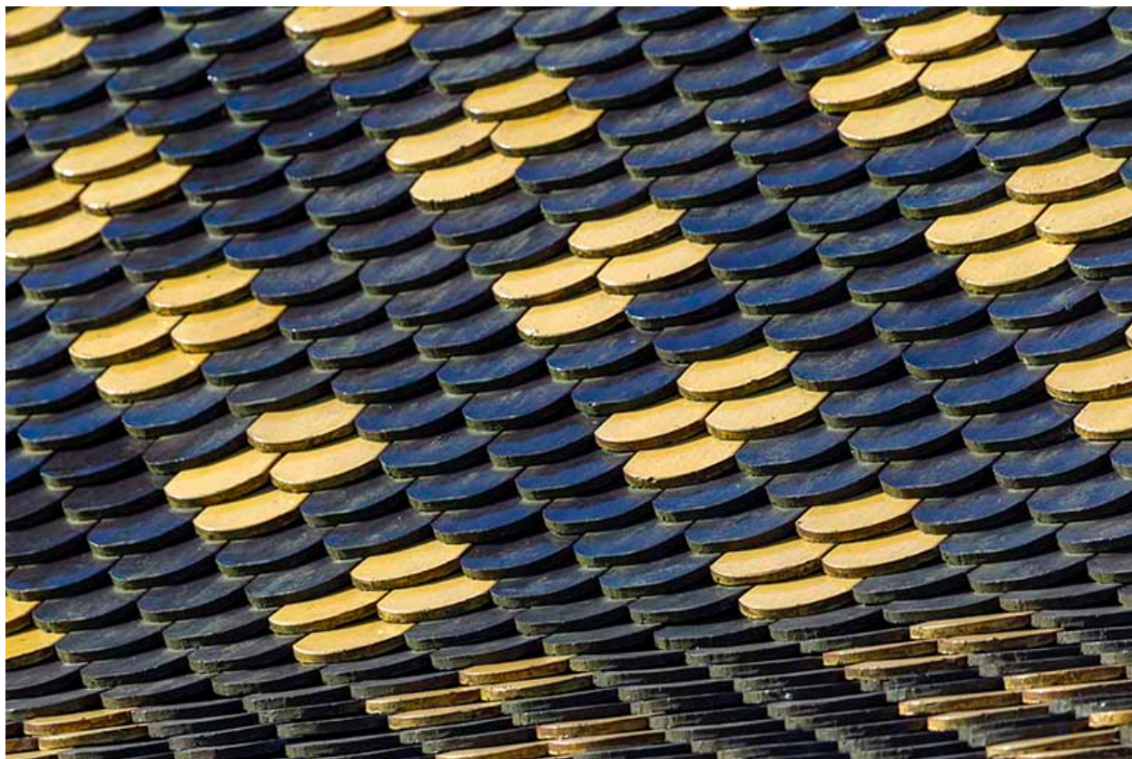
Tuiles vernissées de la toiture.
