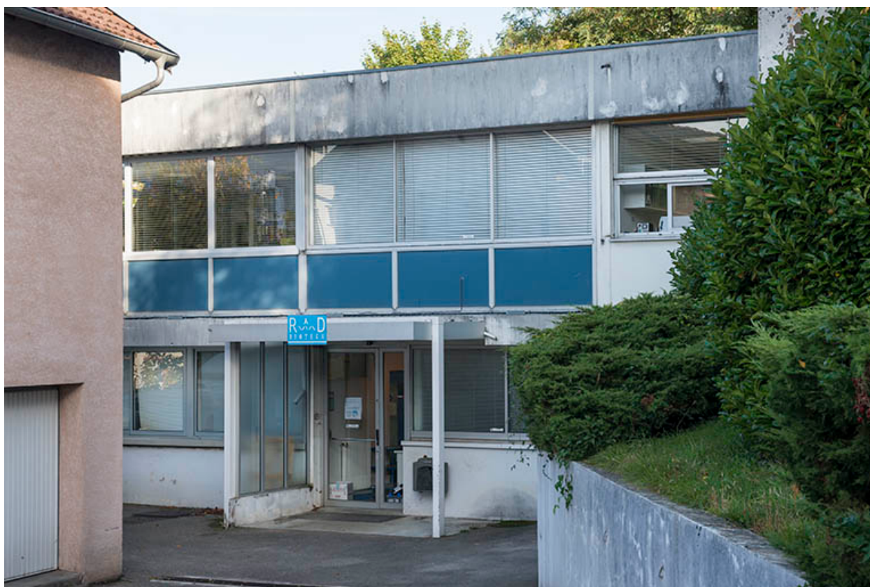
Façade sud de l'extension.
