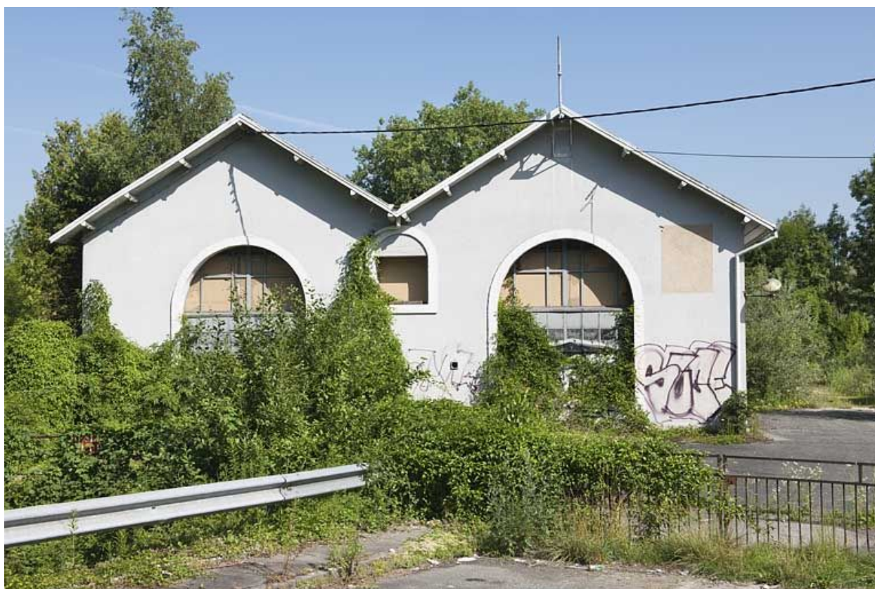
Pignons de la salle des turbines.
