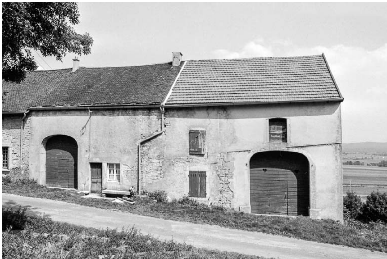
Fermes cadastrées section A : façades sur rue.
