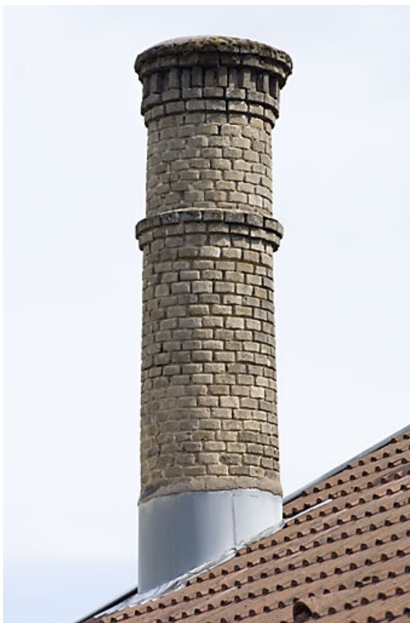
Détail de la souche de la cheminée.
