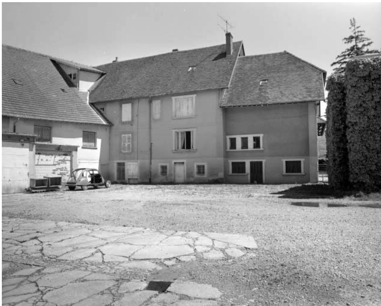
Façade postérieure du logement.
