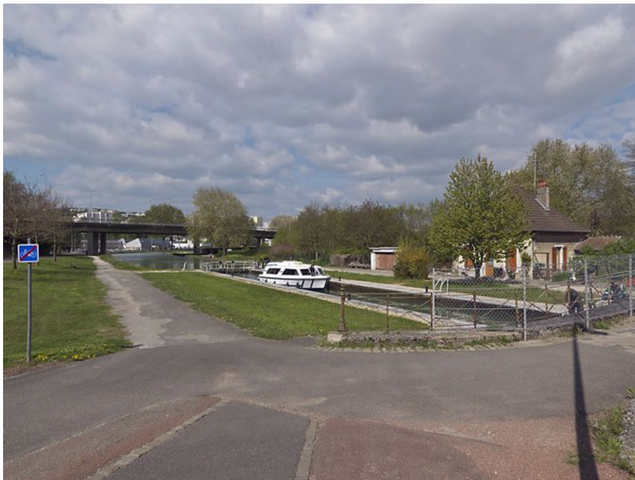
Vue d'ensemble, d'aval.
