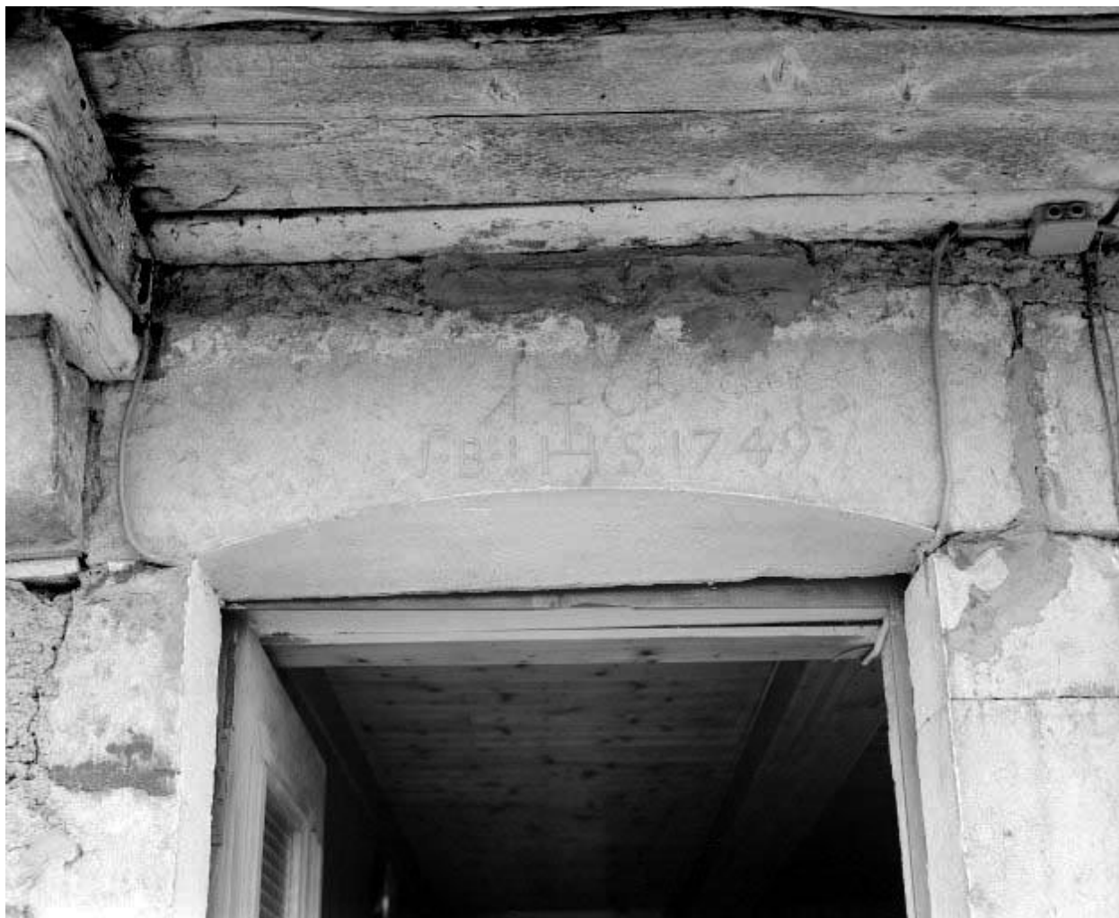
Ferme 2 : linteau de la porte d'entrée.
