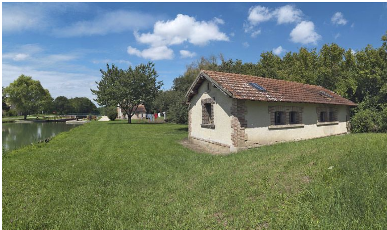
Vue d'ensemble du lavoir.
