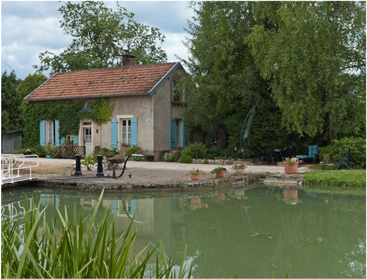
Vue amont du site d'écluse.
