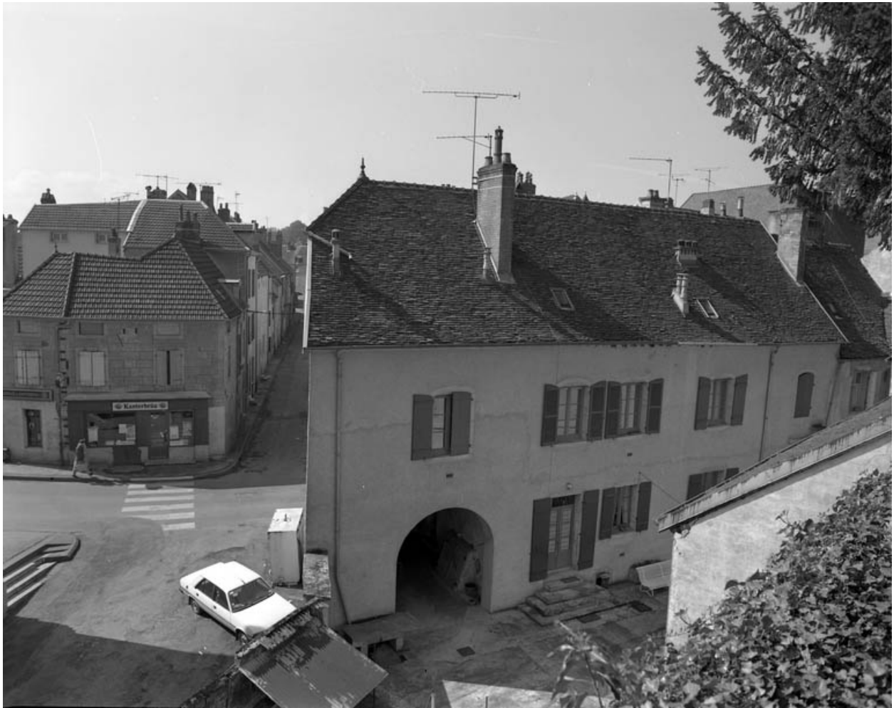
Façade postérieure en vue plongeante.
