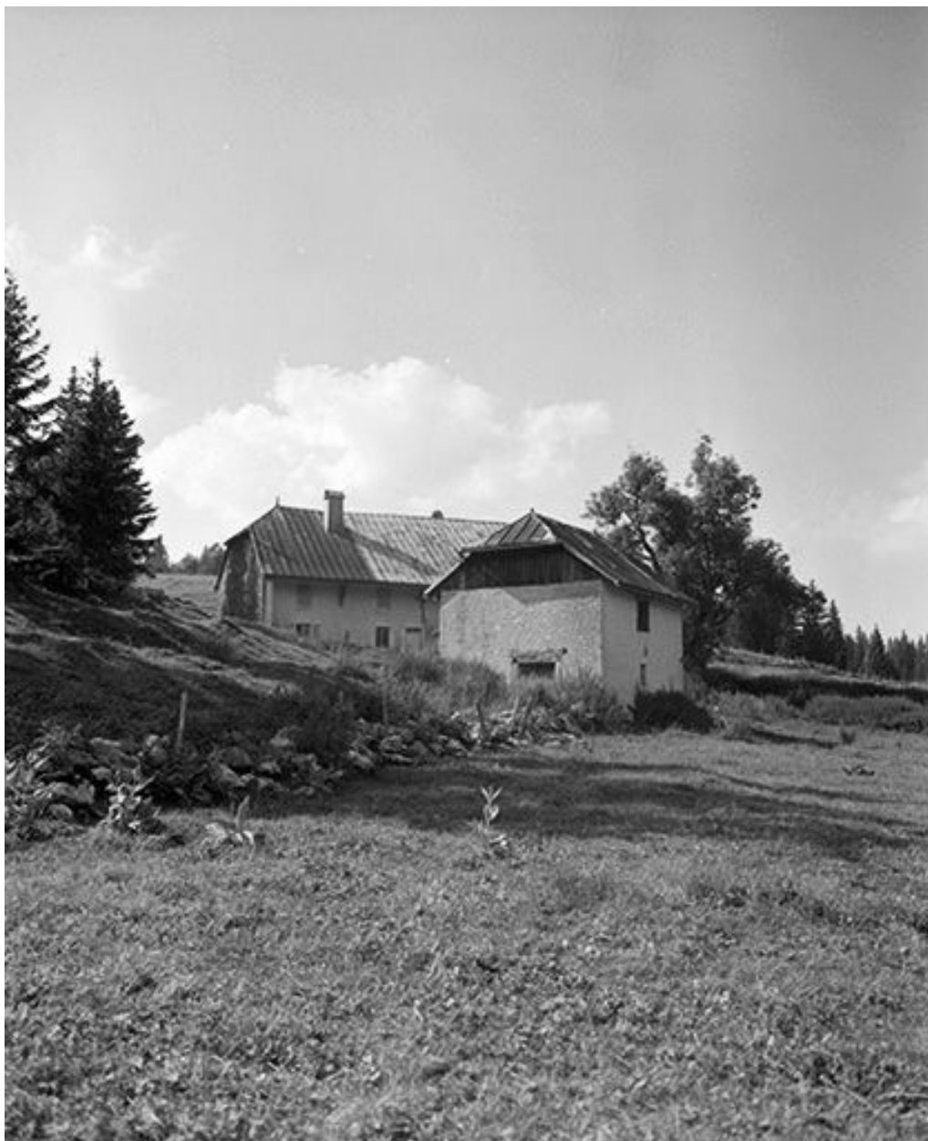
Ferme située au lieudit Pré Poncet : vue d'ensemble.
