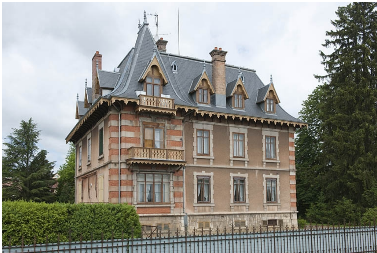
Logement patronal. Façade orientale.
