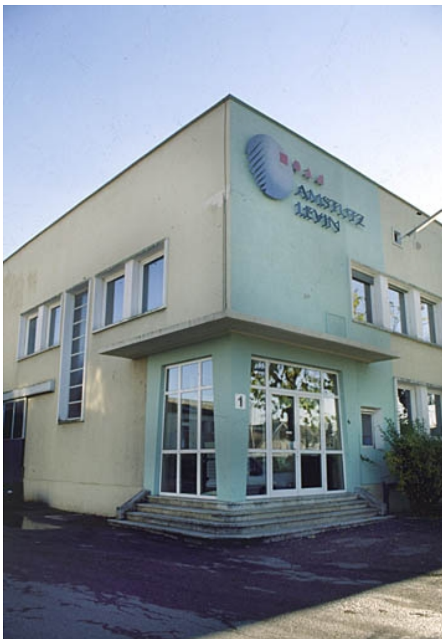
Entrée du bâtiment administratif d'entreprise.
