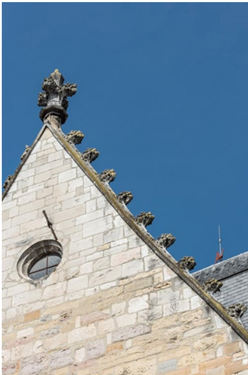
Façade orientale : pignon avec amortissement et crochets.
