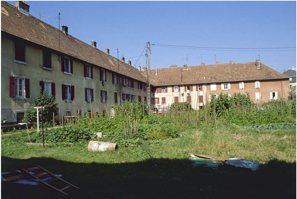
Jardins et logement ouvrier dit la Caserne.
