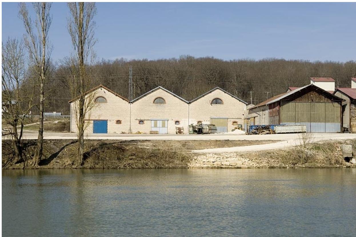
Atelier de fabrication depuis le sud-est.
