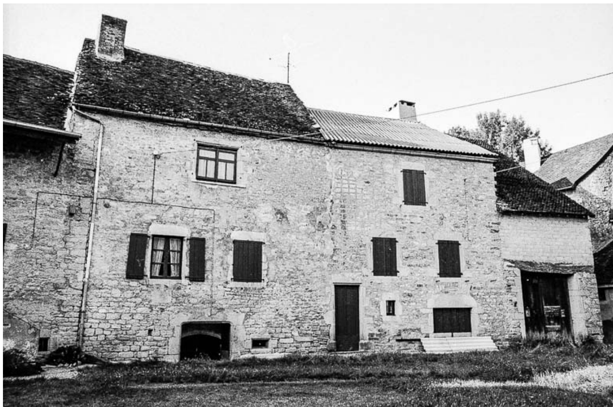
Maisons cadastrées 1960 AI 96-97, situées rue du Puits : façades antérieures.
